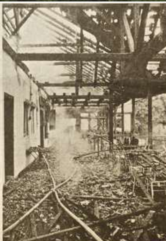
Zahlreiche Dachstatten zersplitterten durch die enorme Hitze und bedeckten und die Gartenstühle vor dem Waldbahn-Eingang.
