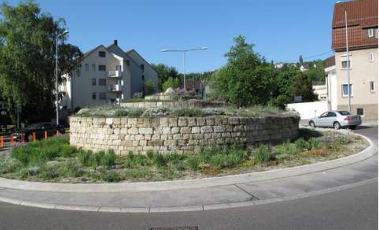
Alte Bauweise für neuen Dürrbachkreisel in Stuttgart-Hedelfingen: Trockenmauer in Schneckenform von Martin Bücheler
