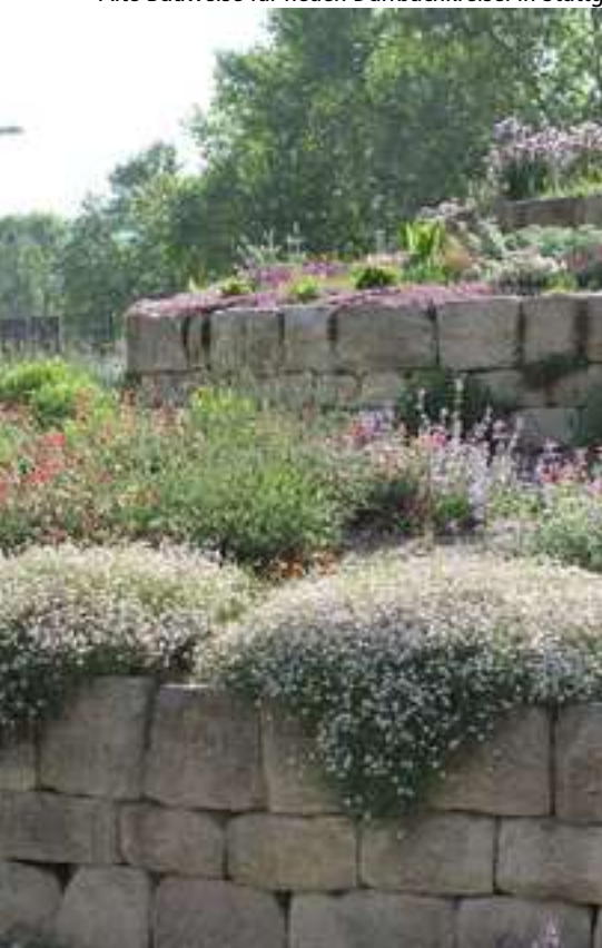
Alte Bauweise für neuen Dürrbachkreisel in Stuttgart-Hedelfingen: Trockenmauer in Schneckenform von Martin Bücheler
