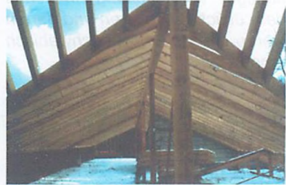
Die neue Dachkonstruktion unseres Vereinsheimes.
