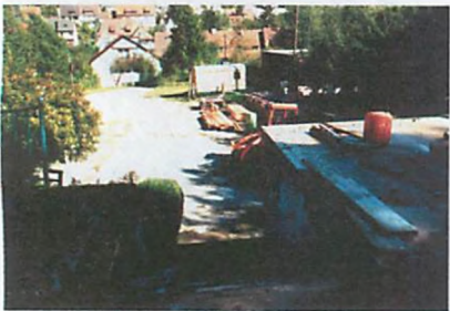
Blick auf die Baustelle beim Gießen der neuen Bodenplatte.
