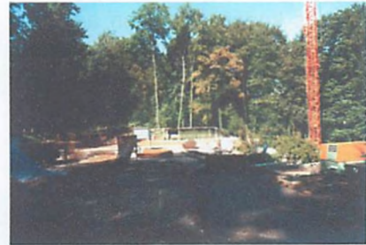
Hier entsteht gerade die neue Bodenplatte unseres Vereinsheimes.
