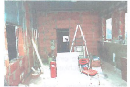
Die Gaststättenküche im Rohbau.
