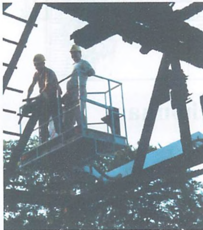
In gefährlichen Höhen mit der Hebebühne im Dachgestühl.
