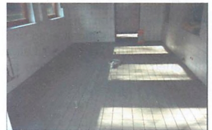
Küche neu gefliest. Hier sieht es jetzt schon erheblich schöner aus.
