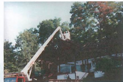
Mit der Hebebühne beim beseitigen des verbrannten Dachstuhls.
