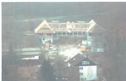
Unser Vereinsheim im Rohbau von den Weinbergen aus gesehen.
