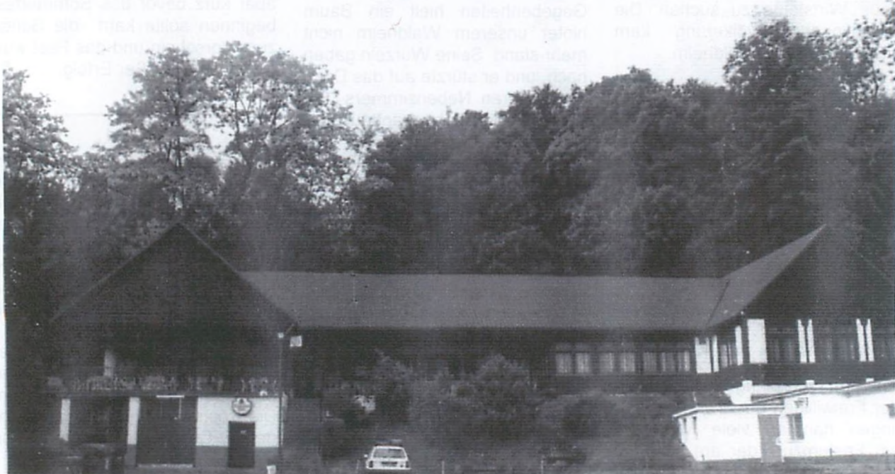
Frühjahr 1992: Waldheim mit neuem Dach
