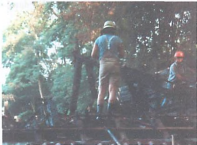
Feuerwehr und THW beim Beseitigen von verbrannten Dachbalken.
