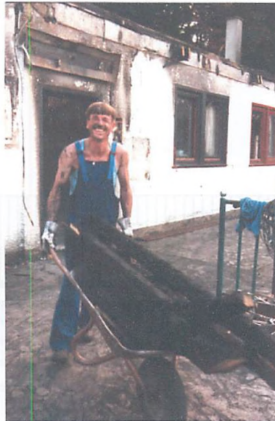
Manfred Schöll mit zersägten Dachbalken.
